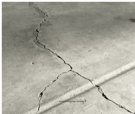
Obr. 2 - Prejav statických trhlín [6]
